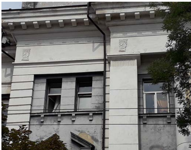
Рис. 2. Елементи державної символіки СРСР перед деконструкцією. Будівля колишнього штабу Південного військового округу, м. Одеса, вул. Пироговська Джерело: фото автора статті
